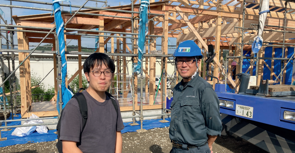
In Japan entstehen Kirchen in kürzester Zeit: Ständerwerk des Neubaus mit Inlandsmissionar Takeda (links) und dem Bauleiter (rechts)
