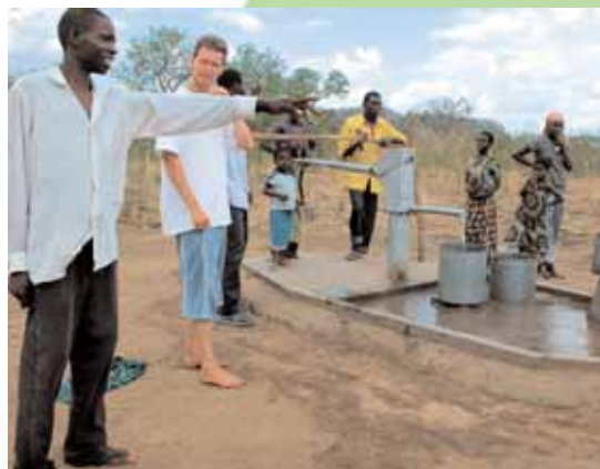
Einige Brunnen konnten mittlerweile gebaut werden.
